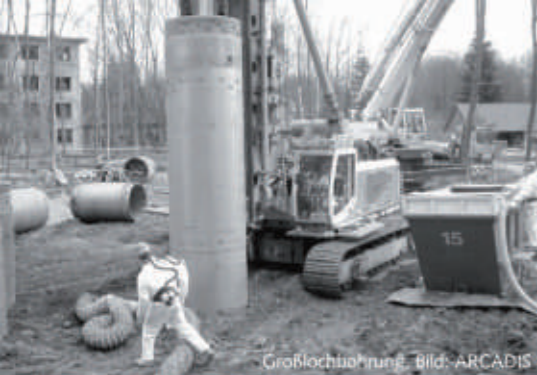
Großlochbohrung. Bild: ARCADIS
